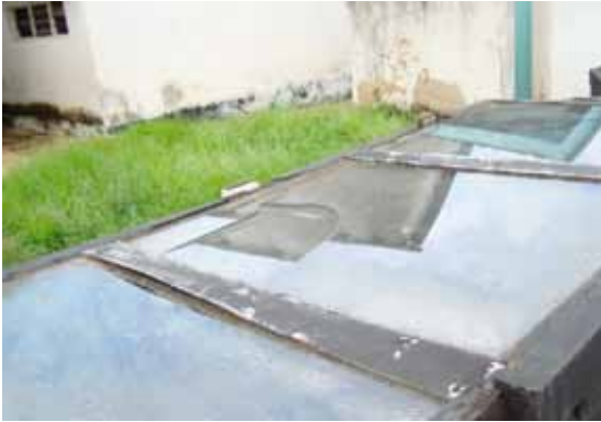
Der Solartrockner mit zerbrochenen Glasscheiben an der Landingsite von Shimoni
