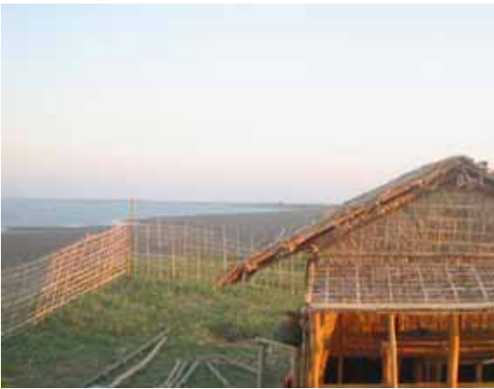
Nach den Stürmen im Oktober 2010 wurden die Sonnenschutzhütte wieder aufgebaut.
