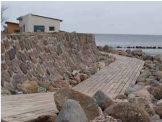
Trotz Steinschüttung und Findlingen bleibt die Ostseeseite vor dem Lotsenhaus über den Steg zugänglich.
