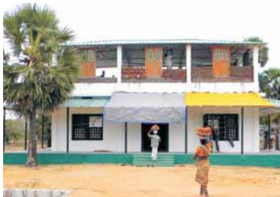
Im Obergeschoß des Centers entstand zusätzlicher Raum.
